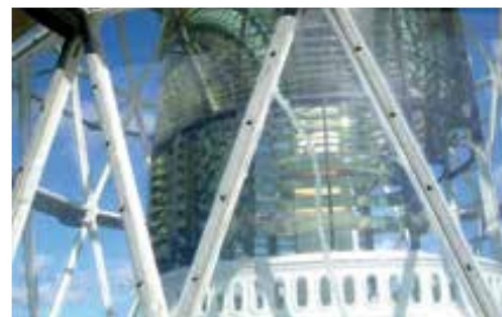
Abb.4: Fresnel-Linse und Lampe des „Bovbjerg Fyr“ an der Westküste Jütlands
